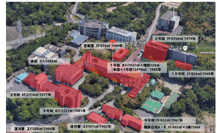
現状：耐震改修未実施建物 約 26,000㎡（赤塗）
